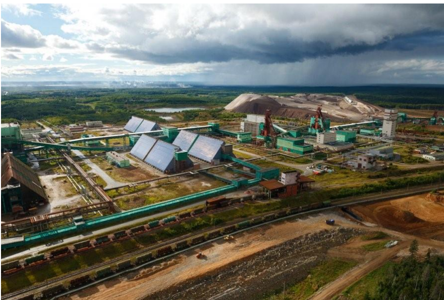
Поверхностный комплекс рудника БКПРУ-4
